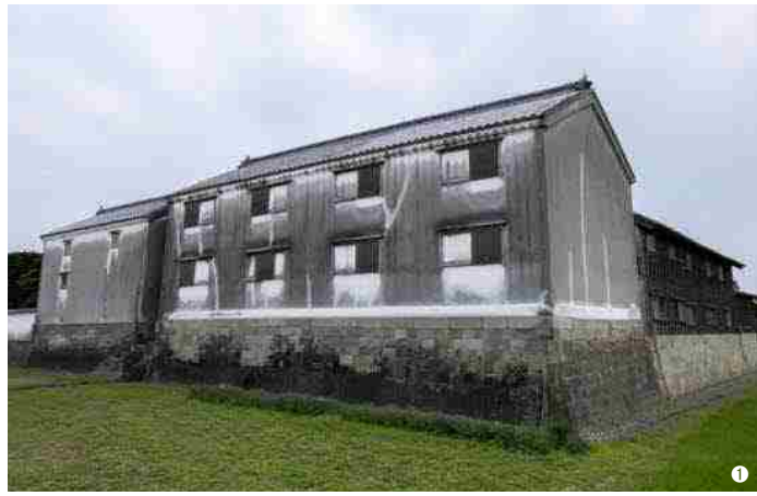
①②田中家住宅（藍屋敷）[MAP-①] 徳島県名西郡石井町藍畑高畑705 洪水対策として石垣が高く積まれている。最も高い石垣で2.7mもある。屋敷内には、脱出用の舟が吊るされており、洪水時には周囲の人々の救出に向かったそうだ。※見学可能（日曜日・祝日のみ）
