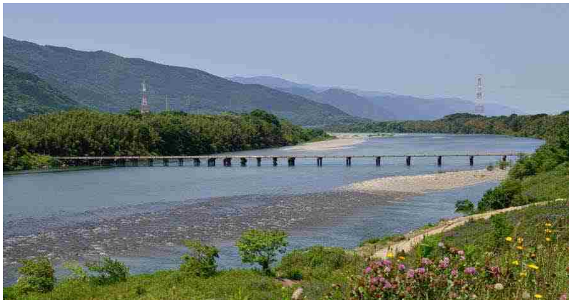
吉野川 写真は、美馬市で見られる景色。台風等の増水時には、潜水橋が濁流の中に隠れ、暴れ川である吉野川の洪水時の迫力が垣間見られる。
