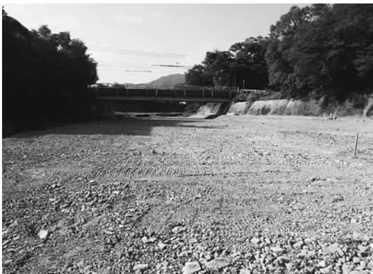
大坂谷川 河川掘削状況
