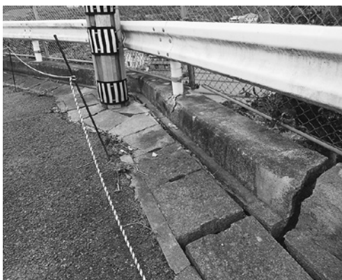
スーパーリッチランド北側道路
