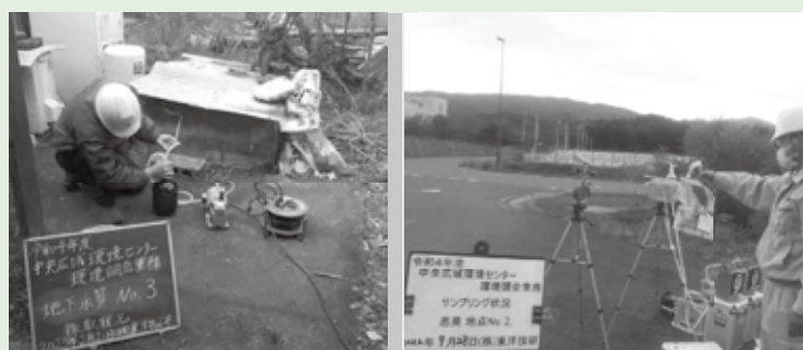
※環境調査は業者により測定を行っています。上の左側の写真は水質調査で、右側の写真は臭気調査の測定を行っている状況です。
