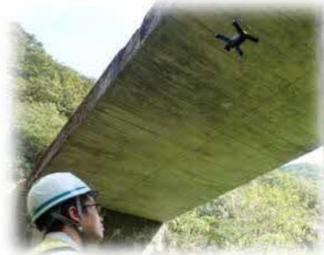
写真－新技術の活用のイメージ(ドローンによる橋梁点検)
