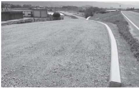
▲工事を行った道路の一部の写真 ※堤防道路(県道122号)付近より西方向撮影
